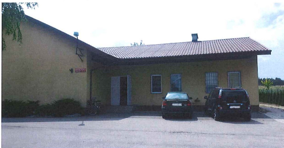
Zdjęcie 1. Świetlica wiejska w Opatowicach
